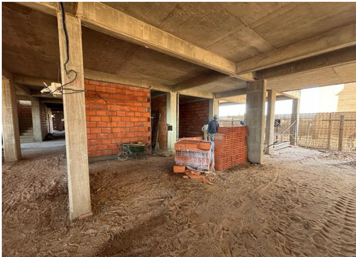
Mampostería en Depto nº8 Planta Baja – TORRE 7
