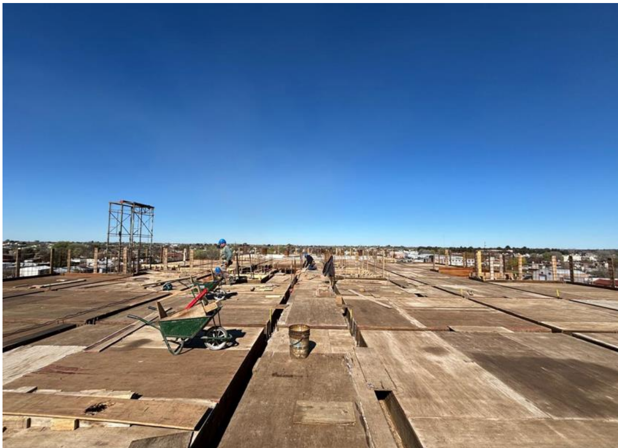
Vista. LOSA SECTOR B – TERRAZA. Preparado de encofrados.
